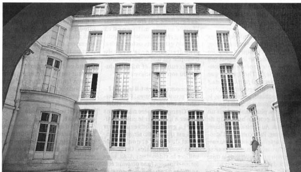
Aucun local n'a été prévu pour entreposer les documents, conservés depuis 1830 à l'Hôtel de Croisilles. Bouchon/Le Figaro.
