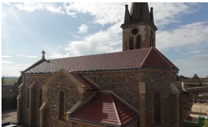
Fin de chantier de l'église Sainte-Anne-sur-Gervonde
