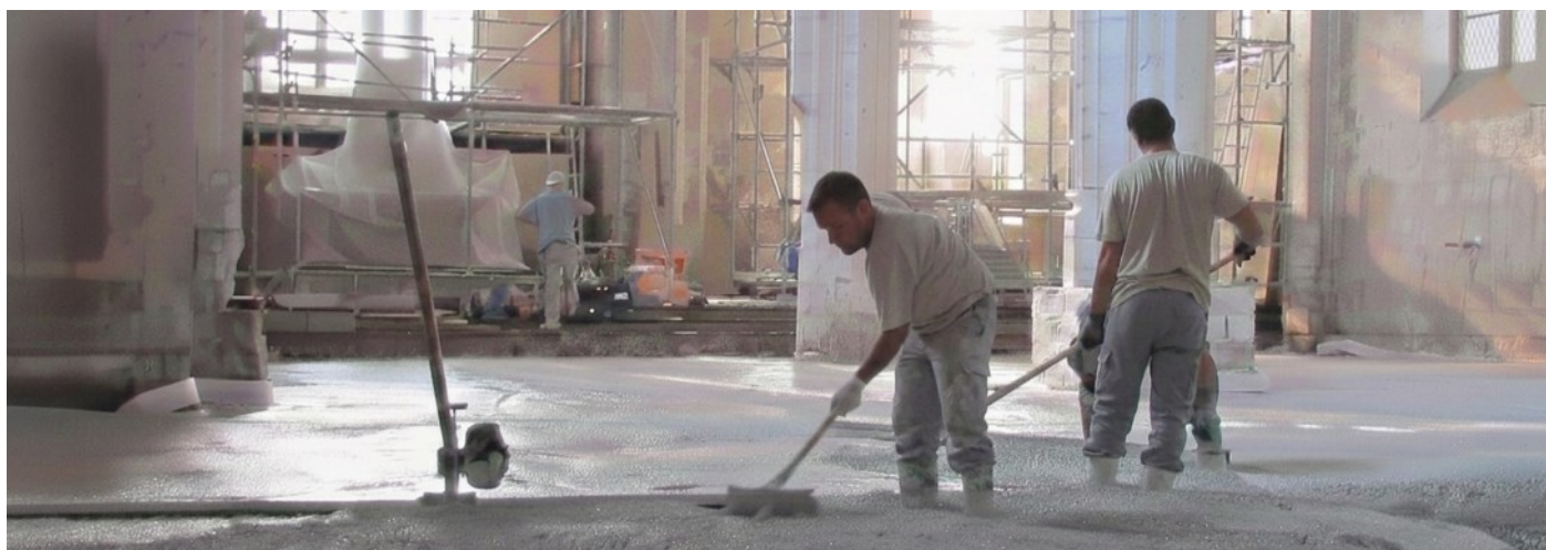
Application du béton de chaux, élaboré à partir de la chaux Nathural NHL 3,5
