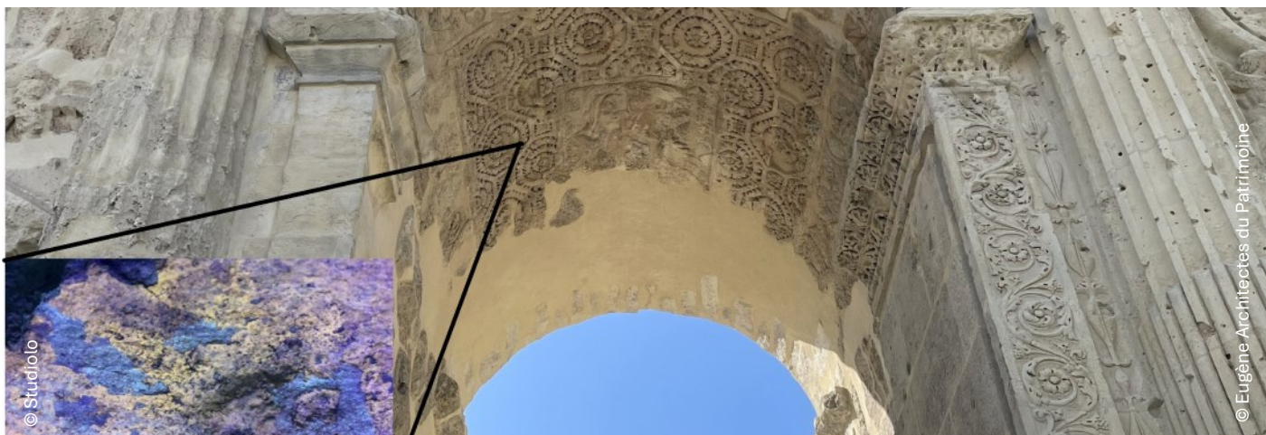
Détail sous lumière ultraviolette de la pierre, consolidée au Paraloid B72 en 1984
