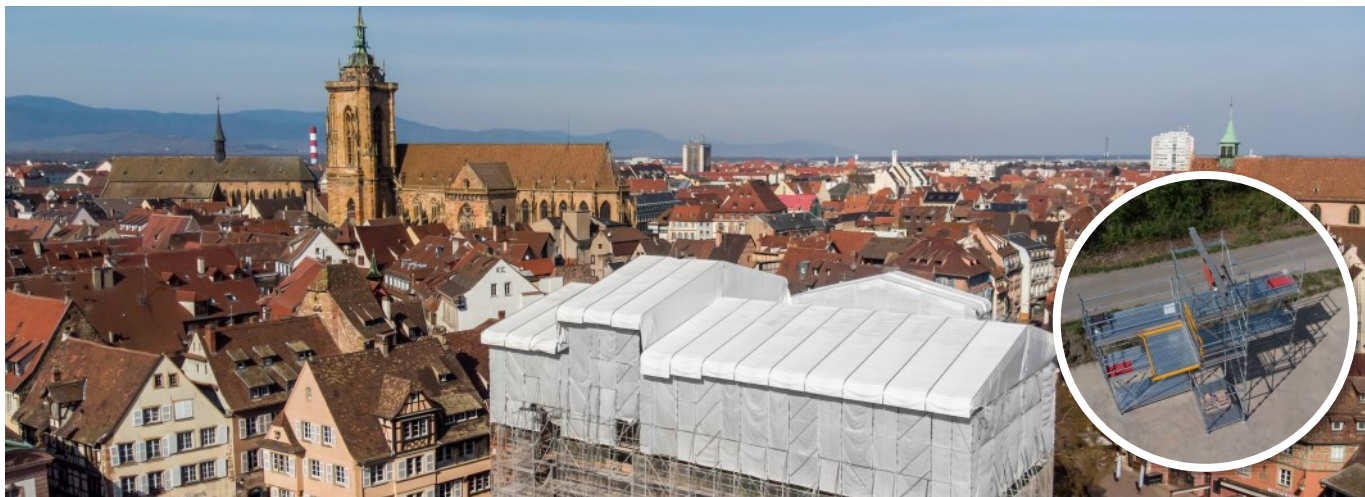
Chantier du Koïfhus à Colmar
