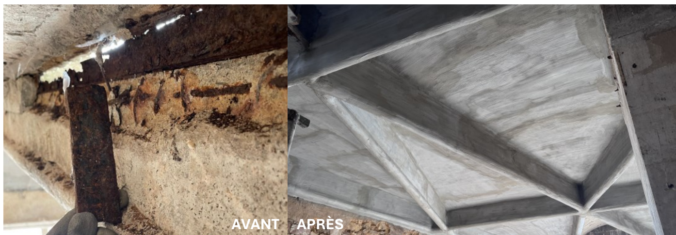
Renfort par treillis carbone CARBOGRID avec mortier de réparation
