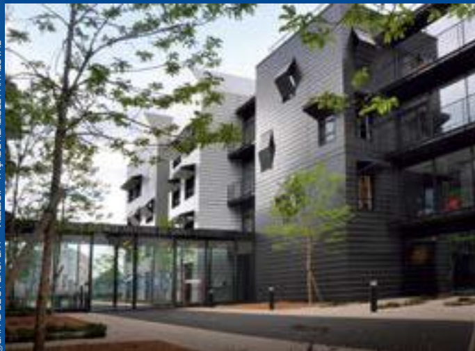
© EHPAD DE ST EXUPÉRY - VILLEJUIF - FAÇADE RÉALISÉE PAR ALUVAL
